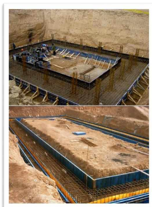
شکل (۲۷-۲) قالب فلزی فونداسیون
