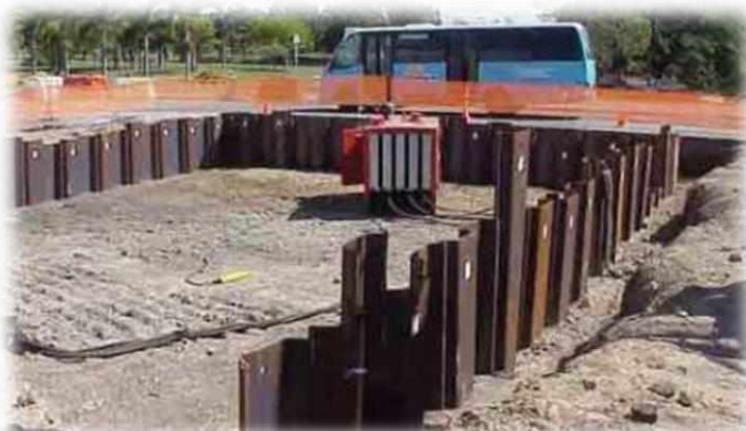
شکل (۸-۲) روش سپر کوبی
