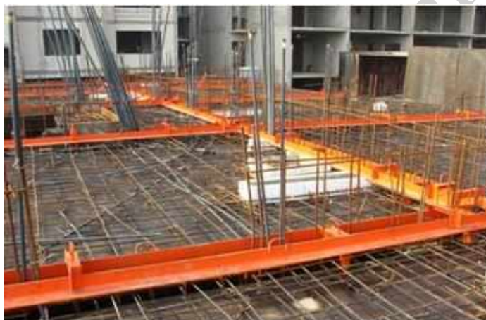
شکل (۳-۲۵) اجرای رامکا در قالب‌های تونلی
