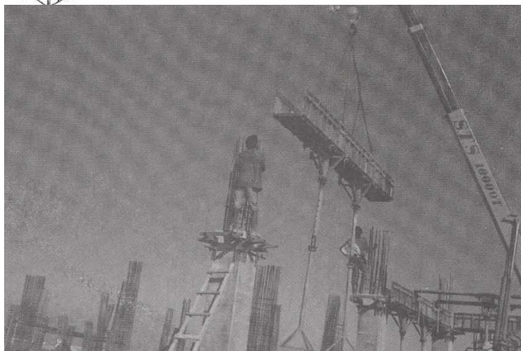
شکل (۳-۲۷) قالب یکپارچه تیر در حال پرواز
